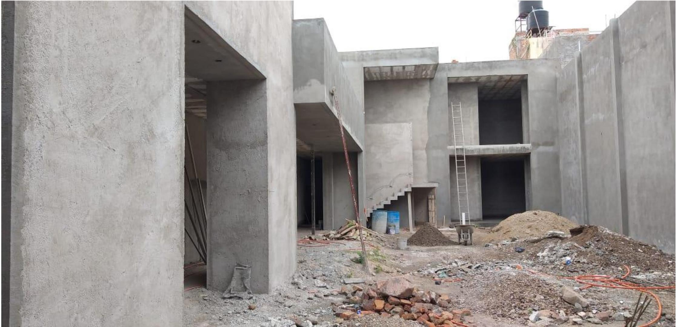
Recubrimiento de muros: zarpeo y afine
